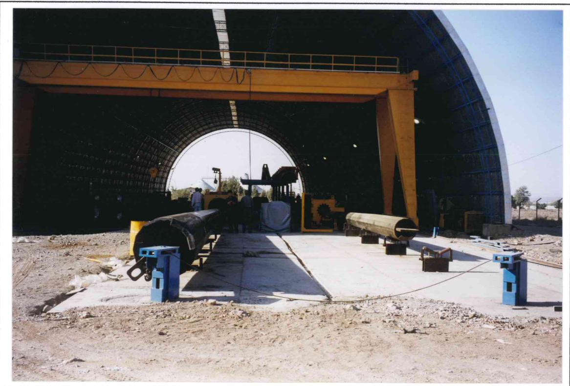
Vue générale de l'usine.
